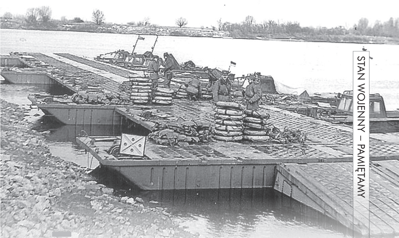
Fragment mostu pontonowego na Wiśle, zbudowanego przez rezerwistów WOI w Chełmnie. Fot. ze zbiorów Archiwum Stowarzyszenia Osób Internowanych „Chełmniacy 1982”
