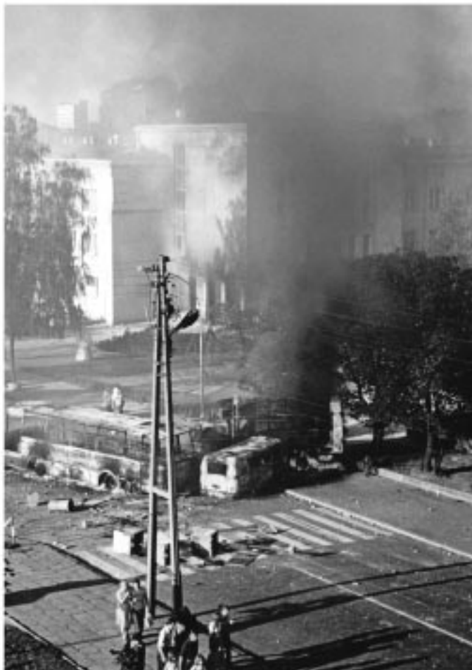
■ SPALONE SAMOCHODY PRZED BUDYNKIEM KW PZPiL
