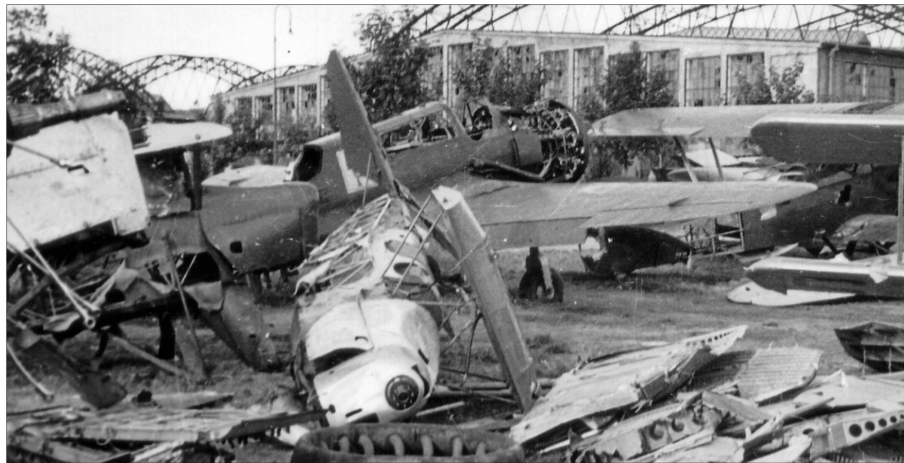
Zniszczenia na lotnisku Rakowice – uszkodzone hangary i samoloty – po nalotach z 1 września 1939 r.
