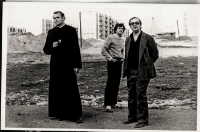
Od lewej ks. Ryszard Dobołowicz, Robert Głuchy, ks. Witold Andrzejewski. Najpewniej teren budowy kościoła pw. Najświętszej Maryi Panny Królowej Polski w Głogowie, pierwsza połowa lat 80. XX w.
