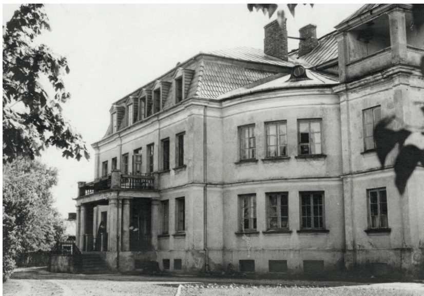
Dom w Płudach przygarnął 40 dzieci pochodzenia żydowskiego.
