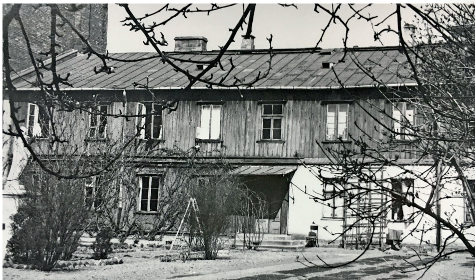
Dom Prowincji, Warszawa, ul. Hoża 53. Widok od strony ogrodu.
