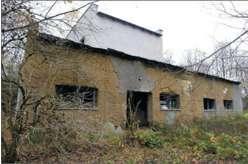
Ryc. 2. Budynek dawnej strzelnicy w opuszczonej wsi Hraničky w powiecie Tachov (fot. L. Funk)
