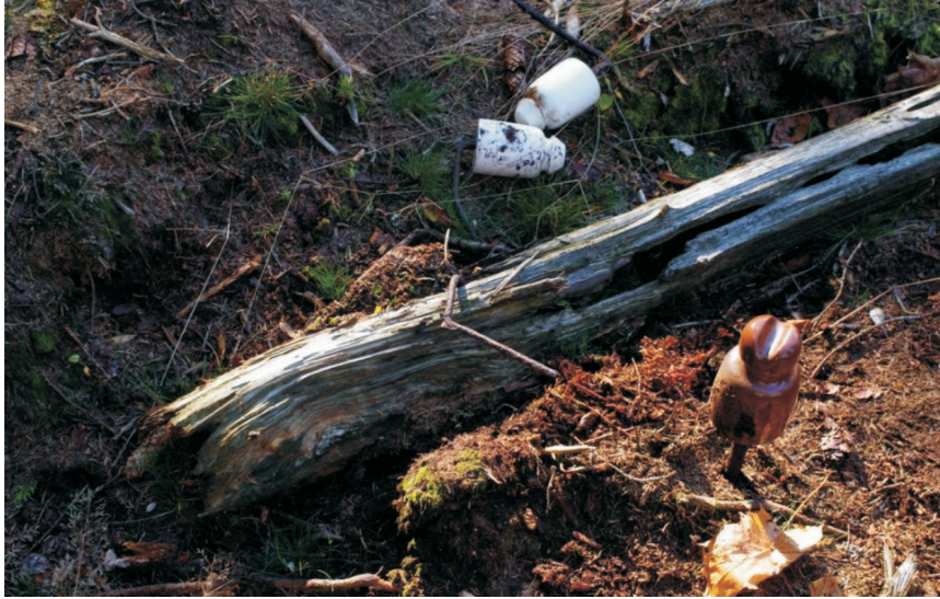
Ryc. 7. Elektryczne izolatory różnych typów z najstarszej fazy „żelaznej kurtyny” (fot. L. Funk)
