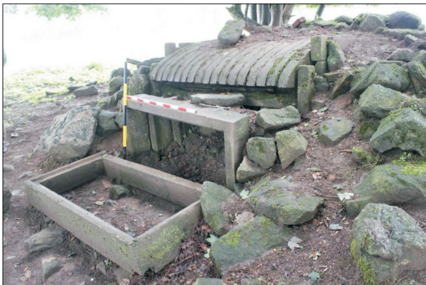
Ryc. 3. Uszkodzony przedwojenny schron w opuszczonej wsi Pavlův Studenec (fot. L. Funk)
