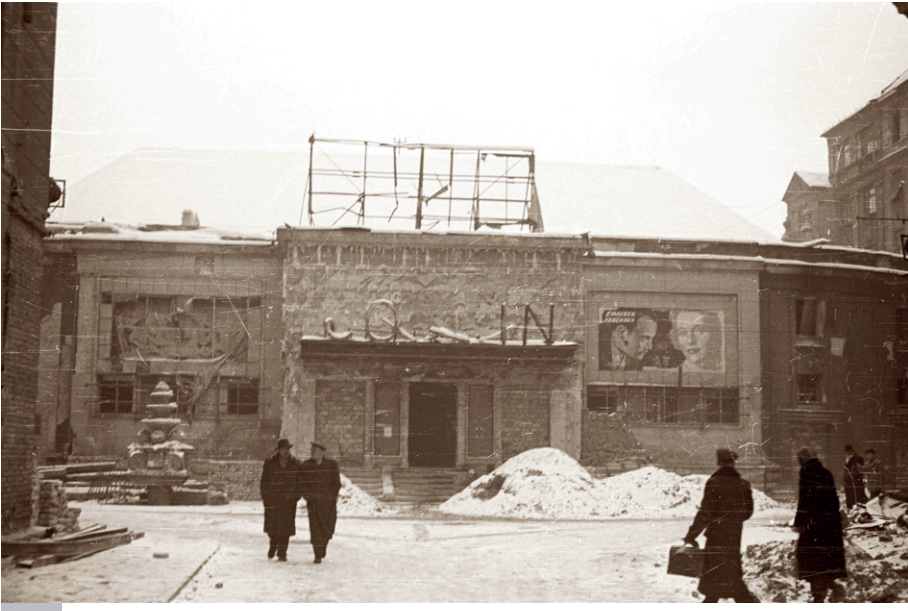
Zniszczony budynek kina „Corvin” w Budapeszcie. Fot. Wikimedia Commons
