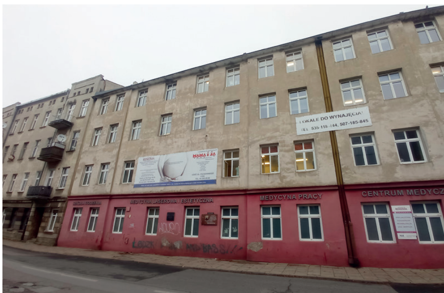
Budynek byłego więzienia policyjnego przy ul. Sterlinga w Łodzi. Fot. ze zbiorów autorki
