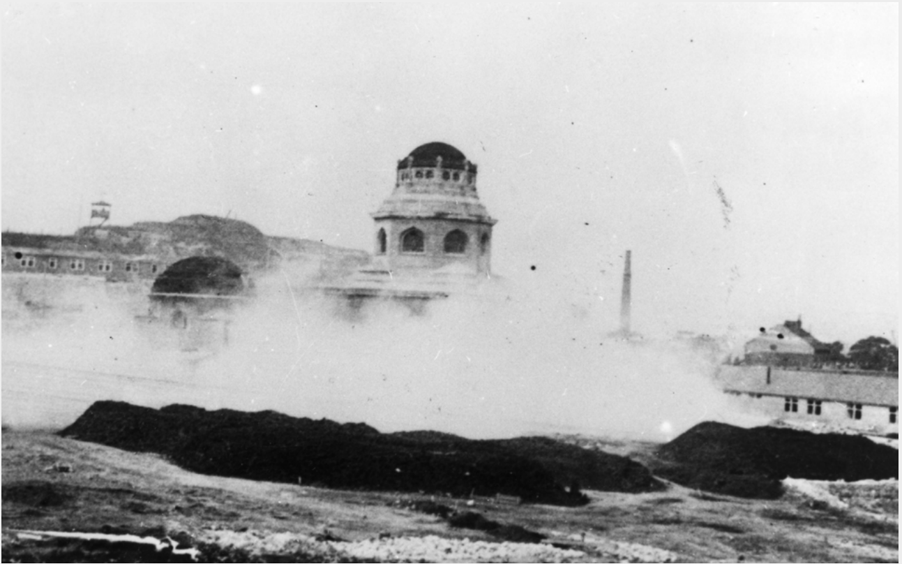
Moment wysadzenia domu przedpogrzebowego wiosną 1944 r. Fot. Instytut Pamięci Narodowej
