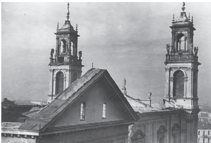
Kościół Wszystkich Świętych. Na zdjęciu widoczne zniszczenia dachu kościoła po bombardowaniach z 12 i 13 września 1939 roku. Zbiory AIPN.
