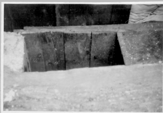
91 Wejście do piwnicy przez parapet. Choć ściana pod oknem w niczym nie różniła się od pozostałych ścian, dodatkowo ustawiono przed oknem deskę.
