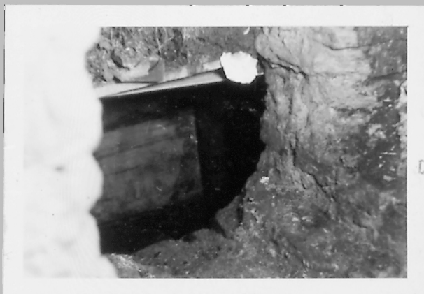
140 Wejście do korytarza. Tu znajdowało się połączenie z kanalizacją.
