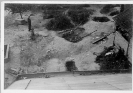
106 Widok na teren schronu z dachu domu widocznego na fot. 18.
