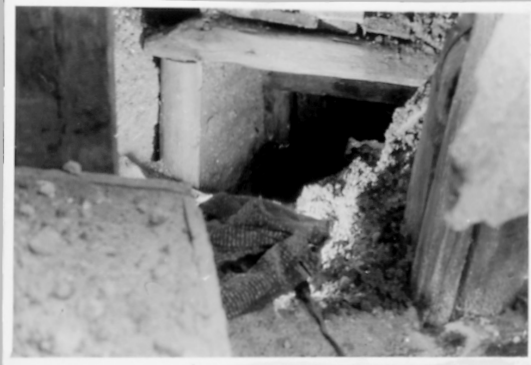
121 Fragment odkrytego schronu, częściowo zasypany z powodu wykopania otworów.
