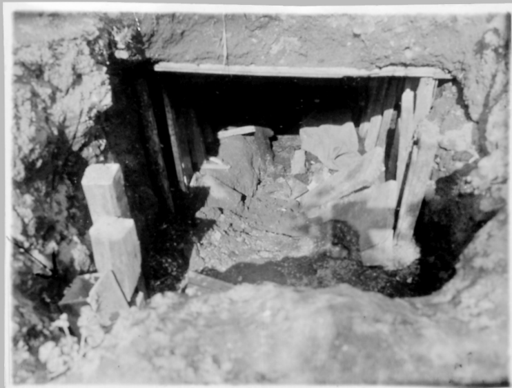
94 Schron pod grządkami w ogrodzie. Rurę wentylacyjną odkryto między ziemniakami. Ponieważ nie można było znaleźć wejścia do tego schronu, zaczęto kopać w pobliżu rury wentylacyjnej i w ten sposób odsłonięto schron. Jego długość wynosiła około 5 m. (Strzałka wskazuje na rurę wentylacyjną).
