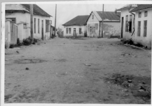
103 Pod tą ulicą znajdował się bunkier. Na prawo dom (fot. 99), na lewo dom (fot. 100).
