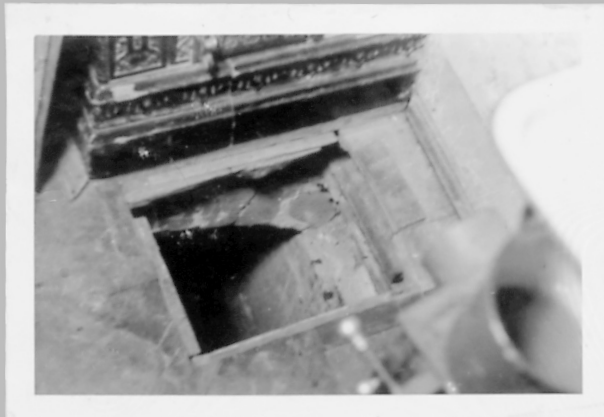
133 Wejście do piwnicy, por. fot. 2.
