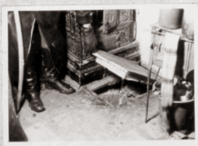
Einstieg zum Keller. Schutzblech vor dem Ofen war auf einen mehrlagigen Holzdeckel genagelt und schloss somit den Eingang un- sicher ab.
