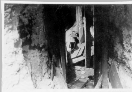
115 Wnętrze schronu. Schron został częściowo zasypany z powodu wykopywania otworów oraz spalania szalunku.
