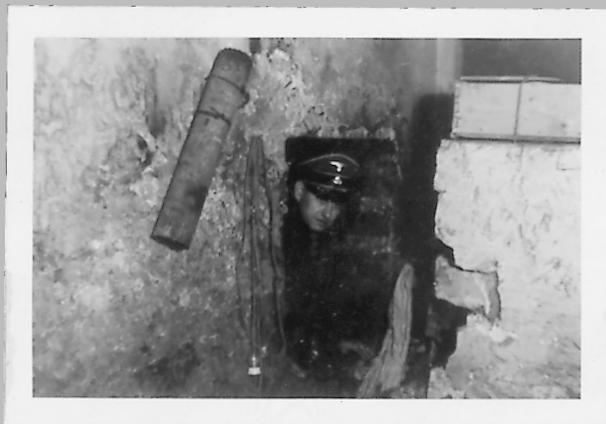
142 Wejście do korytarza. Tu znajdowało się połączenie z kanalizacją.
