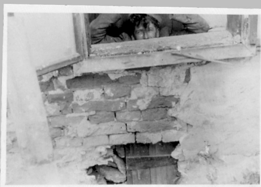
92 Po usunięciu tynku widać drewniane ściany wejścia.
