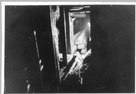
120 Wnętrze schronu. Częściowo zasypane po spalaniu drewnianego szalunku.
