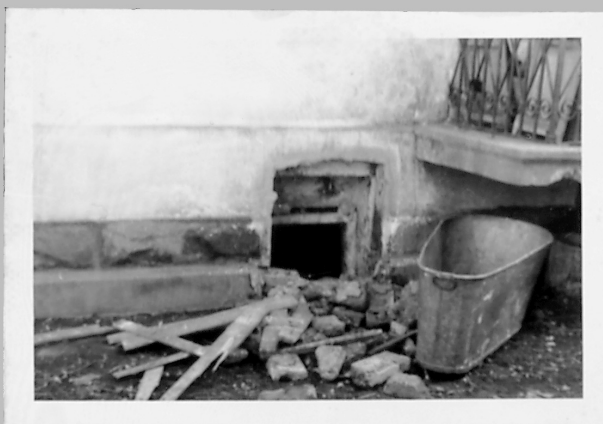
131 Zamurowane okienko piwniczne.
