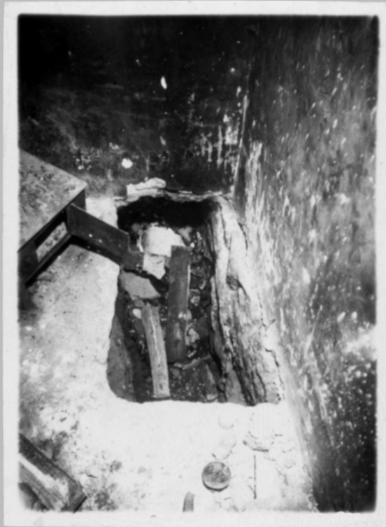
128 Zejście do pomieszczenia pozbawionego okien i drzwi. Szerokość pomieszczenia wynosi 1,5 m.
