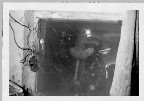
137 Przejście do drugiej piwnicy.
