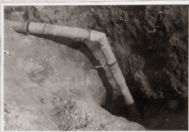
Entlüftungsrohr aus dem Bunker.
