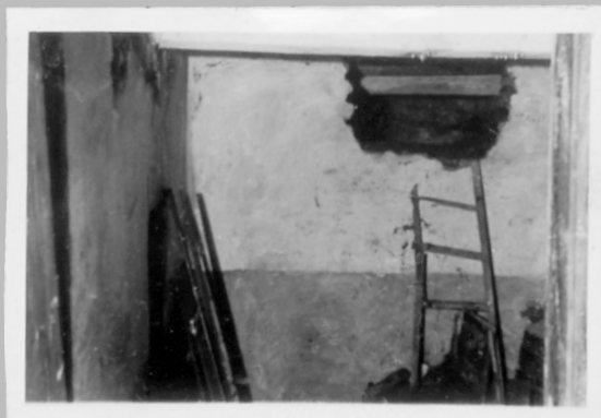
101 Poza piwnicą znajdującą się w domu widocznym na poprzednim zdjęciu, Żydzi mogli przebywać w bunkrze wyłącznie w pozycji kłęczącej bądź siedzącej. Aby wyciągnąć ich z kryjówki, należało rozbić ścianę domu – przez otwór w ścianie można było zajrzeć do piwnicy (fot. 100).
