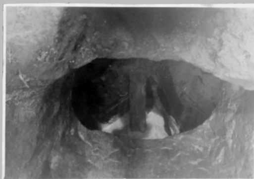
116 Wnętrze schronu. Schron został częściowo zasypany z powodu spalania szalunku.
