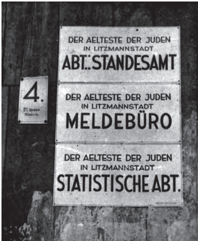
Il. 18. Szyldy Wydziału Stanu Cywilnego, Biura Meldunkowego, Wydziału Statystycznego na budynku przy ul. Miodowej 4. (Archiwum Państwowe w Łodzi)
