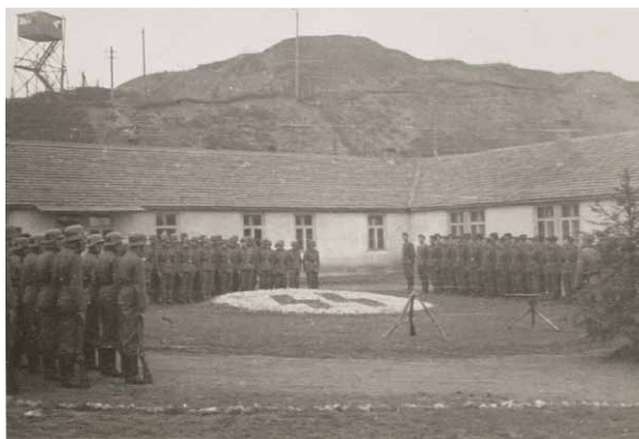
fot. 31 i 32 Apel załogi przed budynkiem komendantury
