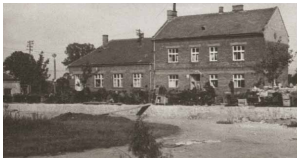
fot. 29 Budynek dawnej centrali telefonicznej i kasyna w 1944
