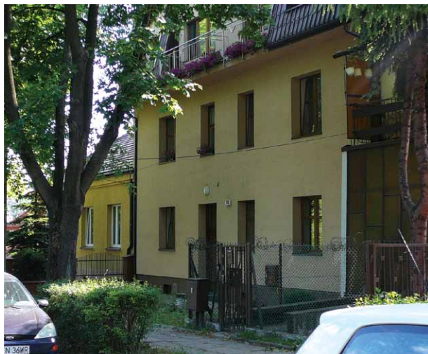
fot. 30 Budynek dawnej centrali telefonicz- nej i kasyna – widok współczesny
