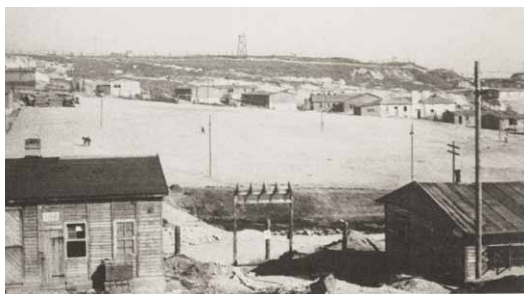
fot. 43 Widok na plac apelowy. Na pierwszym planie barak warsztatu szewskiego i ze- garmistrzowskiego oraz staw przeciwpożarowy. Powyżej m.in. obiekty łaźni i odwieszalni
