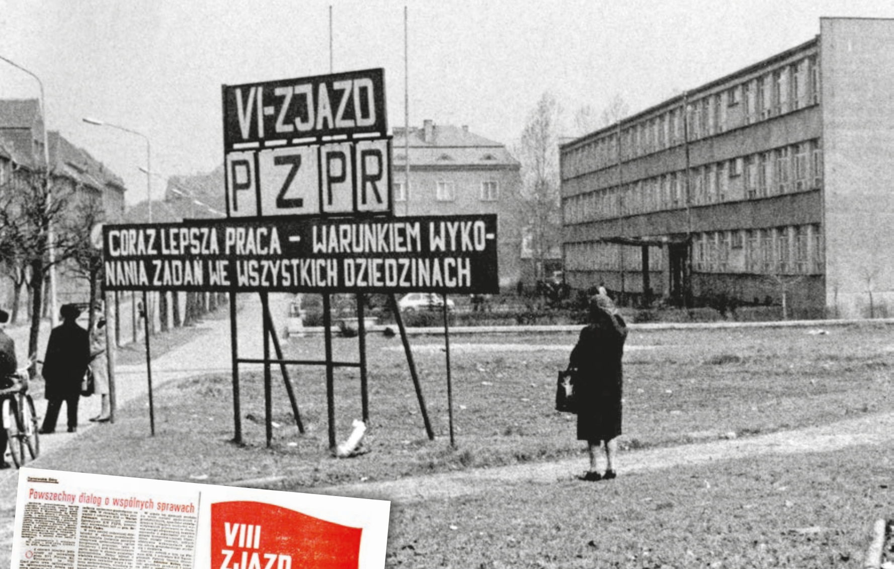
Powyżej: Typowa „propaganda wizualna”: wszechobecne hasła podkreślające przewodnią rolę PZPR. Tarnowskie Góry, ul. Sienkiewicza, po prawej Technikum Mechaniczno-Elektryczne. 1971 r. Fot. Archiwum „Gwarka”
