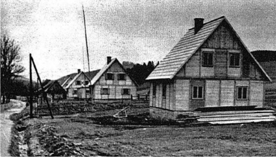
Budowa domów dla robotników leśnych (Beskidy, brak dokładnej lokalizacji). Źródło: BA Lichterfelde
