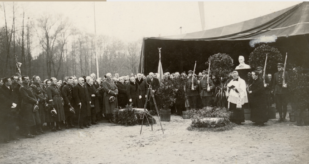
Poświęcenie kamienia węgielnego pod budowę Domu Legionistów na krakowskich Oleandrach, listopad 1928 r. (zbiory Muzeum Historycznego Miasta Krakowa)
