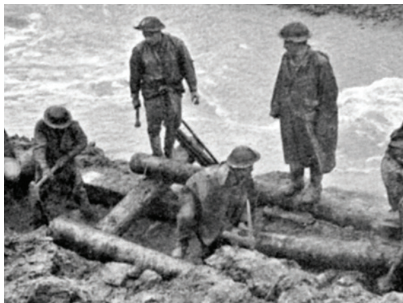
Budowa drogi przez polskich saperów. Fot. Mieczysław Herod
