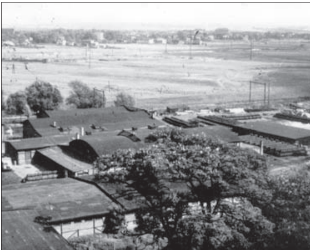
Zabudowania Obozu Pracy w Mysłowicach; lata sześćdziesiąte.
