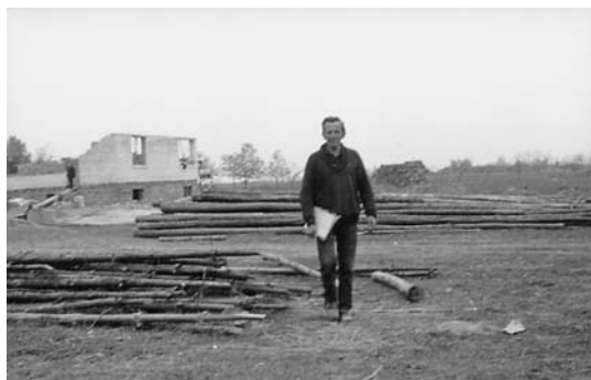
Ks. Czesław Sadłowski na tle budowy kościoła parafialnego, 1973 r.
