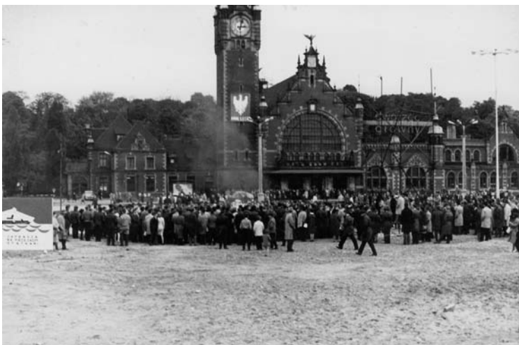
Widok na Dworzec Główny. Po prawej rusztowanie, z którego wcześniej zrzuciono plansze
