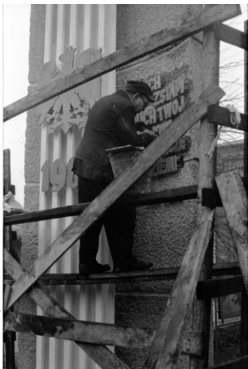
Budowa pomnika – Krzyża Doli Kolejarskiej w Lokomotywowni PKP Lublin, upamiętniającego strajk lubelskich kolejarzy w lipcu 1980 r.
