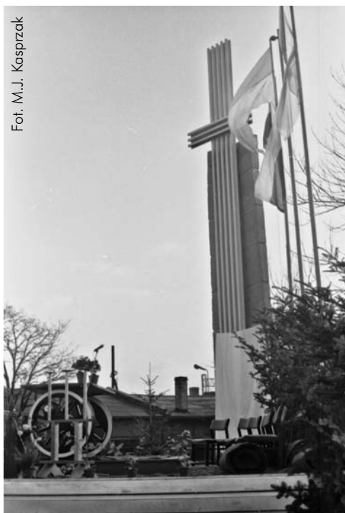
Pomnik – Krzyż Doli Kolejarskiej w Lokomotywowni PKP Lublin, odsłonięty 25 listopada 1981 r.
