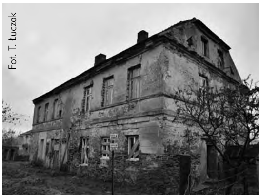
Oficyna przy dworze w Kopojninie, pow. Sępólca, 2010 r.
