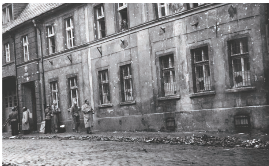
Widok na ul. Kasprowicza. Budynek KM MO po 30 maja 1960 r.
