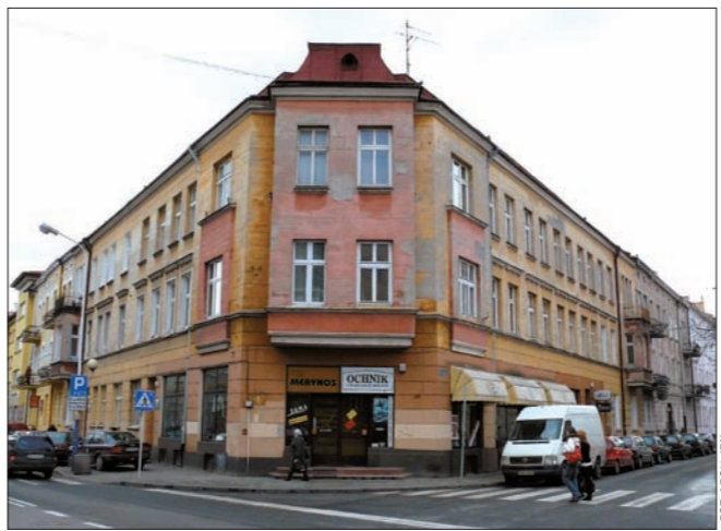
Kamienica przy ul. Tannenbauma 12 – widok współczesny
