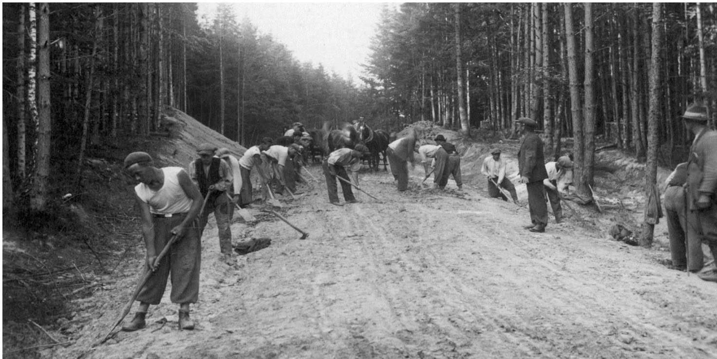
Budowa drogi gminnej w Zmiennicy (woj. lwowskie). Fot. NAC
