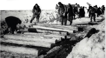
Transpolarna Magistrala Kolejowa – od początku bezsensowna: już po kilku latach od rozpoczęcia budowy stała się niepotrzebna i zaczęła niszczeć, stając się Martwą Drogą
