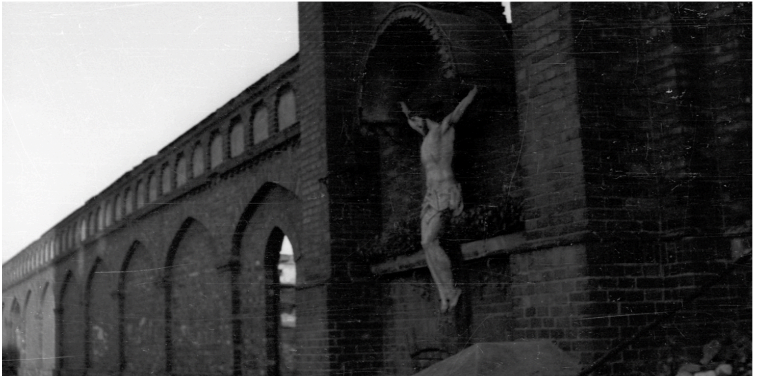
Ocalały po Powstaniu Warszawskim krucyfiks z fasady kościoła św. Rodziny przy ul. ks. Siemca 7/9 (dziś ul. Wiślana), Warszawa, 1947 r. (fot. ze zbiorów Muzeum Powstania Warszawskiego)
