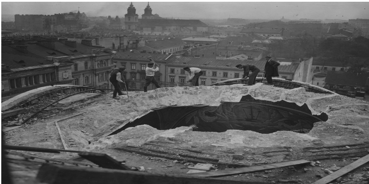
Rozbiórka soboru św. Aleksandra Newskiego, maj 1925 r. Fot. NAC
