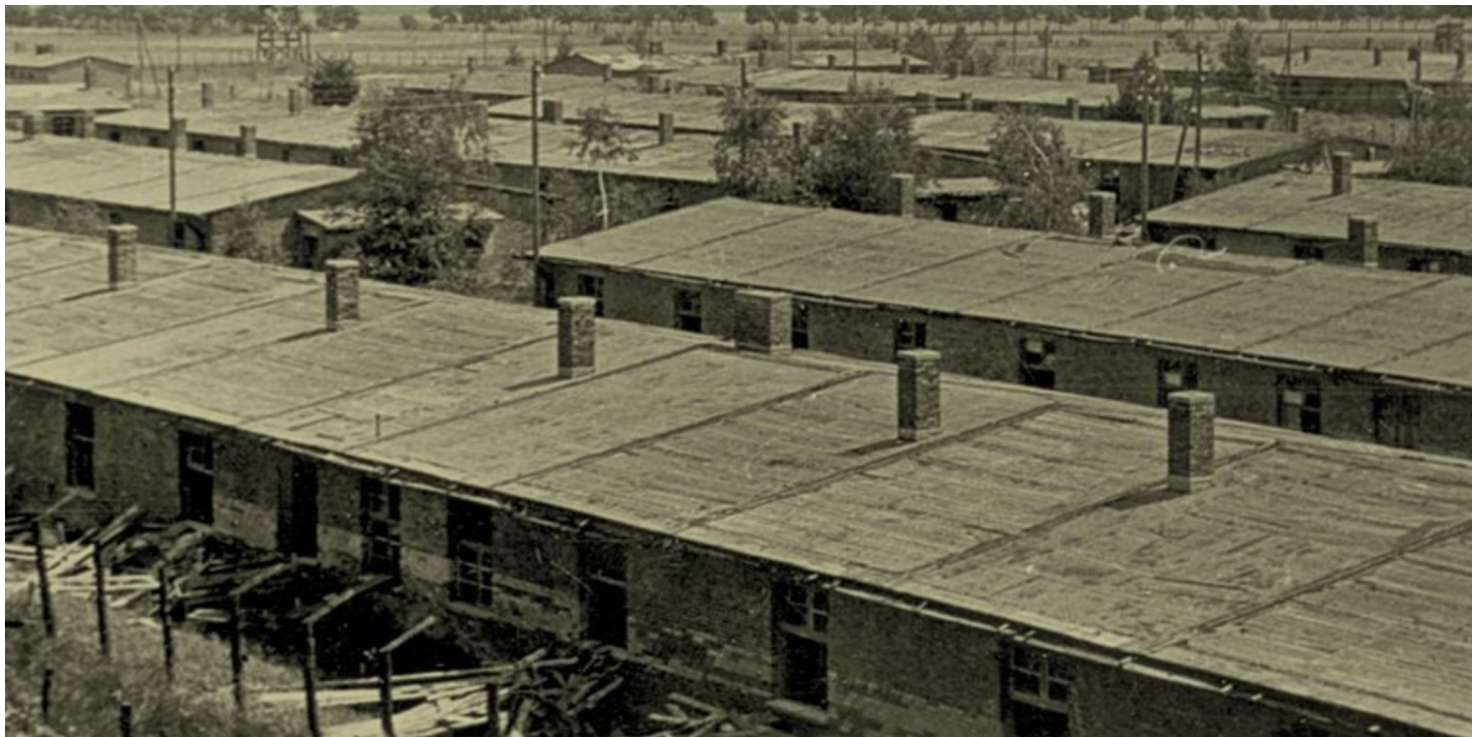
Baraki Oflagu II C - prawdopodobnie w fazie budowy; zbiory Muzeum Woldenberczyków
