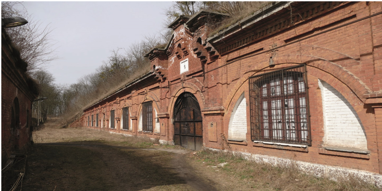
Fort III w Pomiechówku – wejście do cel. Fot. Piotr Jaźwiński
