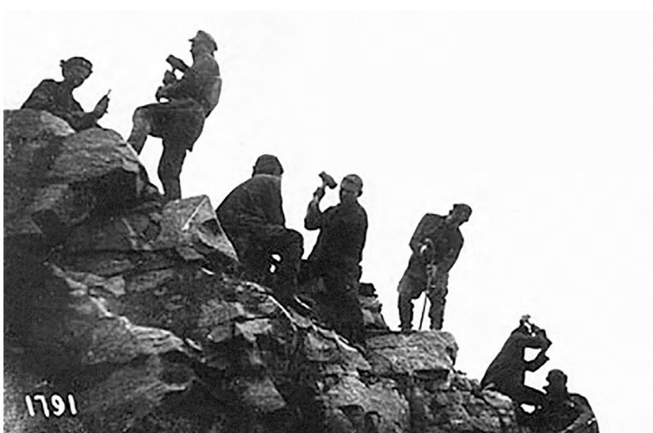
53, 54. Łagiernicy przy budowie Kanału Białomorsko-Bałtyckiego, lata 1930–1933. Domena publiczna.
