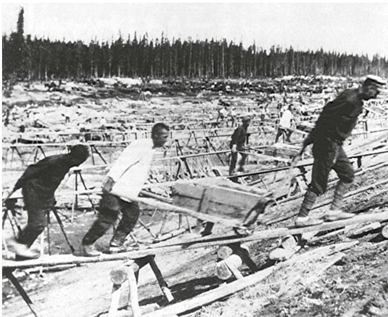
52. Łagiernicy przy budowie Kanału Białomorsko-Bałtyckiego, lata 1930–1933. Domena publiczna.
