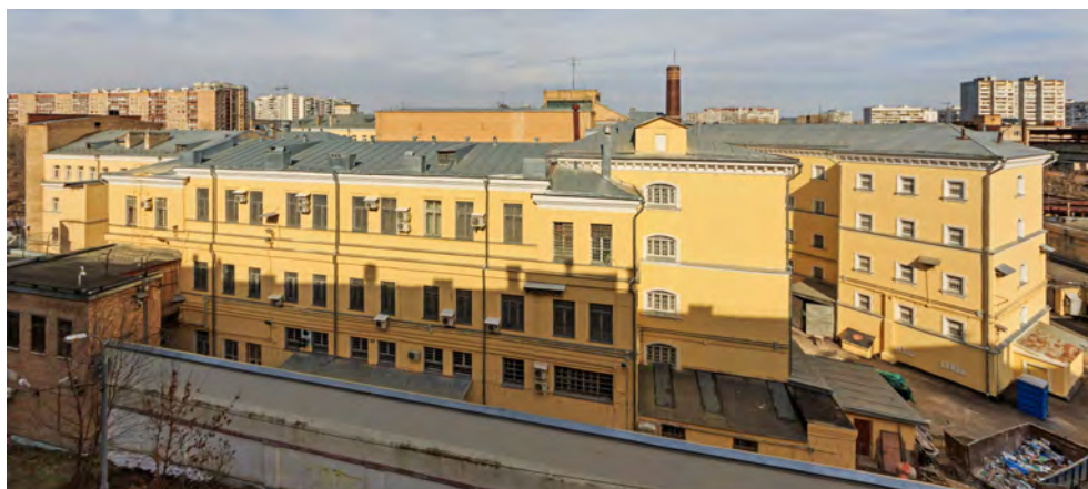
165. Więzienie Lefortowo. Fot. Savin, Wikimedia Commons.
