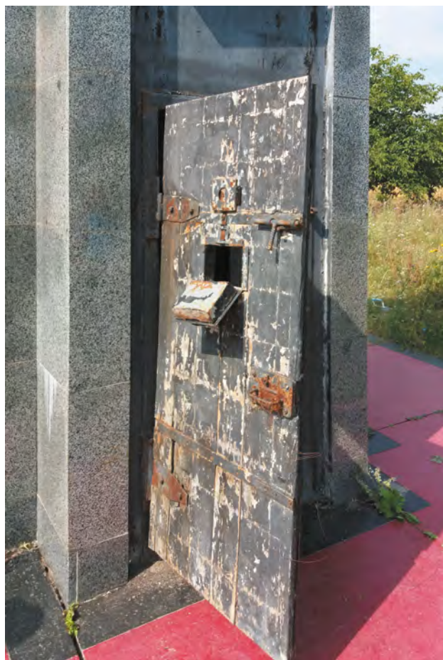
119. Tylna ściana pomnika z drzwiami więziennymi.
