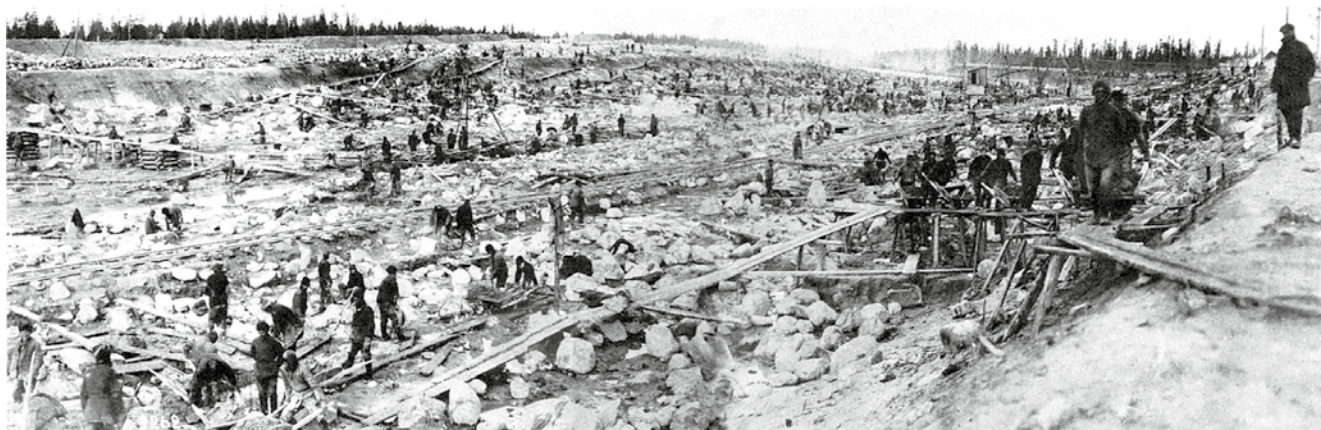
51. Kanał Białomorsko-Bałtycki w budowie, 1932 r. Domena publiczna.
