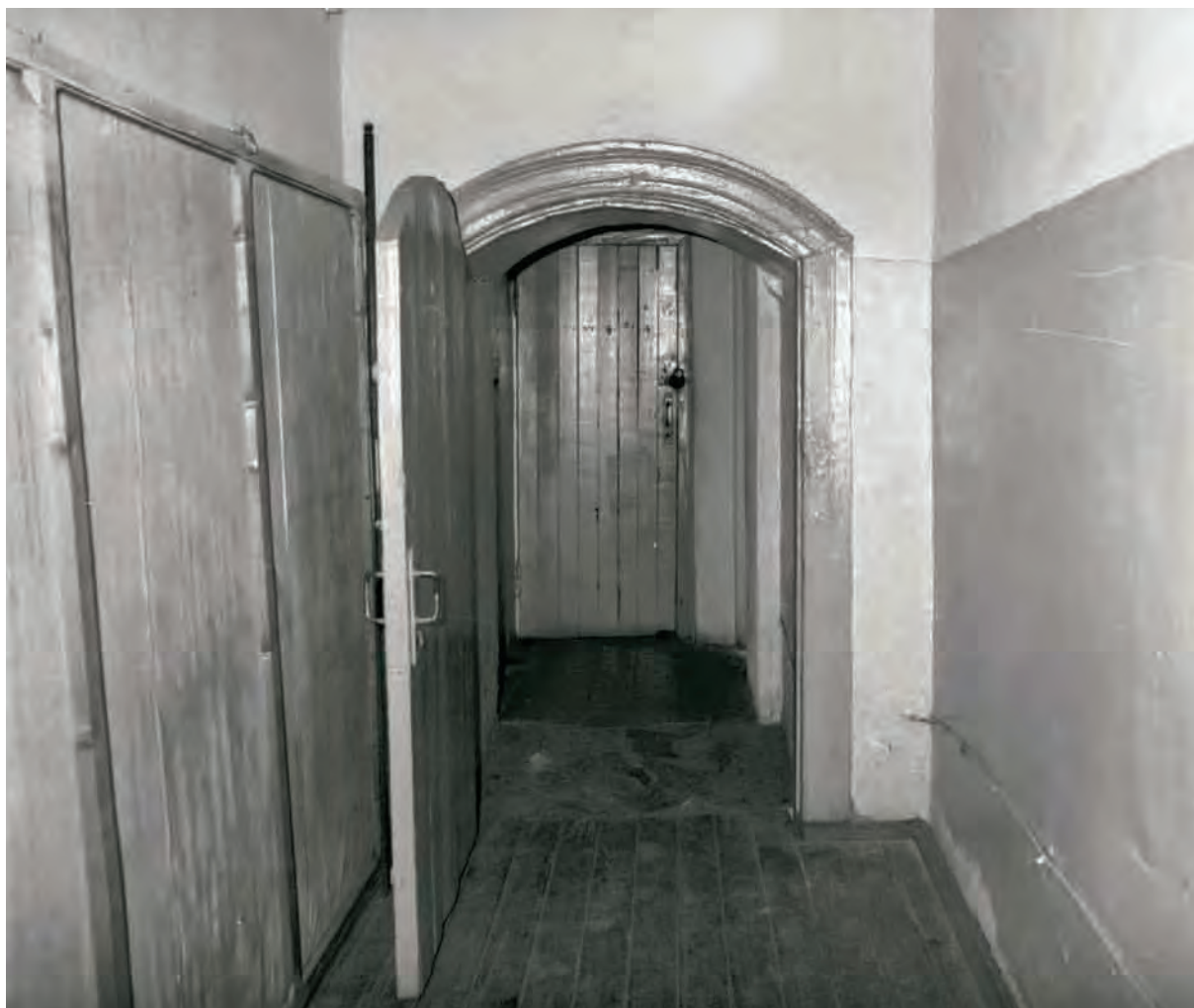
▲ Basement corridor. (Photo Aleksander Załęski)
