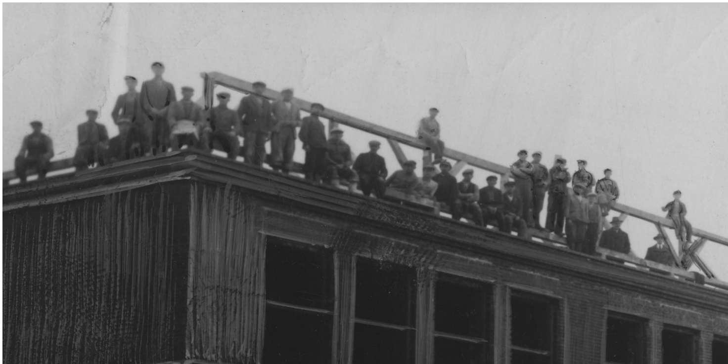
Budowa szkoły w Bolesławcu, 1937 r. Fot. NAC
